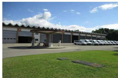
Les garages et pompes carburants
