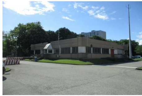
Le Poste de Police
