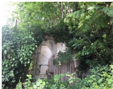
La casemate des munitions, sous le chenil ...
