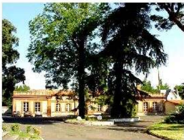
Le bâtiment du foyer et de l'ordinaire
